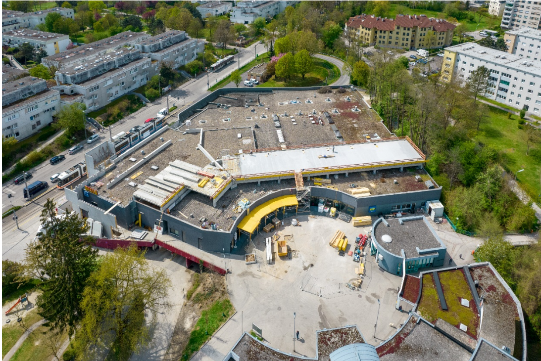
Aktuelle Situation auf der Baustelle
