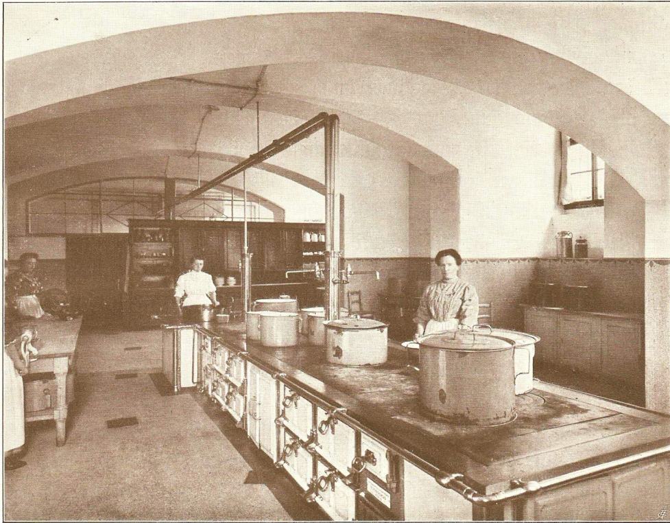
Anstaltsküche im Hauptgebäude
