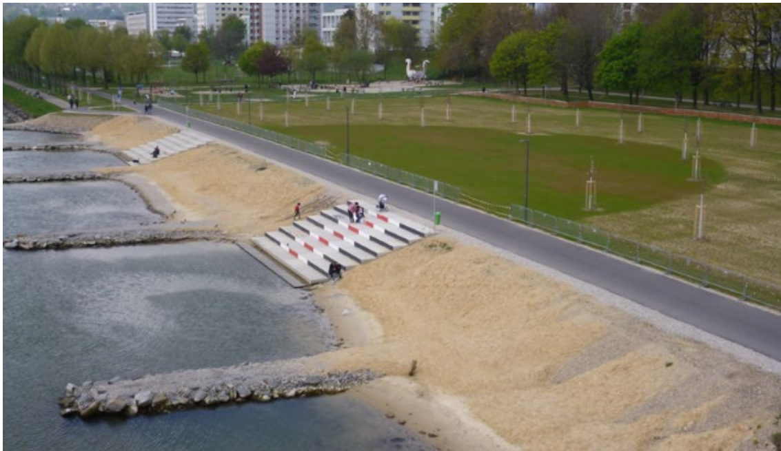
Ehemaliger Montageplatz für die neue Eisenbahnbrücke
