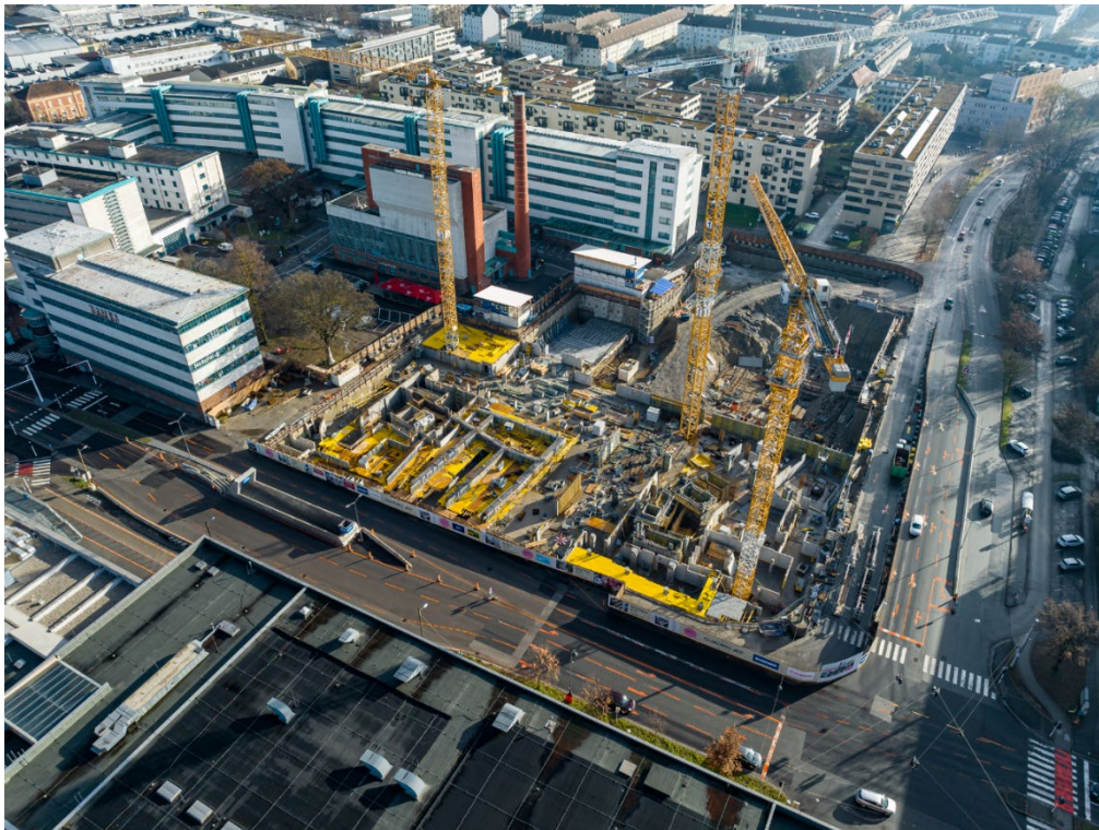
Das Quadrill-Ensemble zählt zu den größten in Bau befindlichen Projekten in Linz, PTU/Pertlwieser
