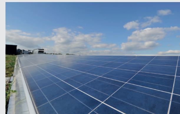
Die LINZ AG hat ihre Photovoltaik-Leistung bereits im Jahr 2018 fast verdoppelt. 2019 wird um weitere 0,665 MWP aufgestockt.
