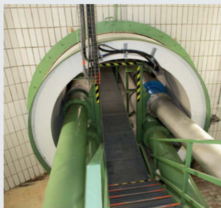
Durch den Donaudüker verlaufen künftig neben Abwasser-, Wasser- und Glasfaserleitungen auch Stromleitungen.
