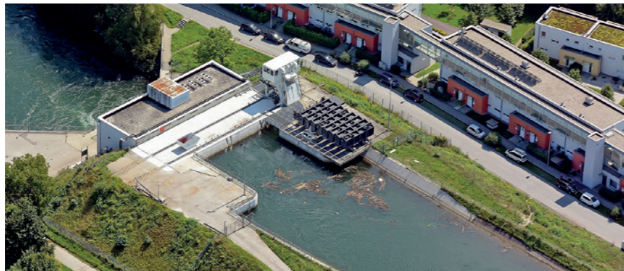
Die LINZ AG-Tochter LINZ STROM GAS WÄRME GmbH erzeugt Strom unter anderem im Kleinwasserkraftwerk Kleinmünchen. Kürzlich erhielt sie das TÜV-Zertifikat „Nachgewiesene Stromherkunft“.
