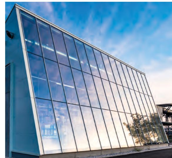
In der Pilotanlage H2Future wird „grüner“ Wasserstoff produziert.
