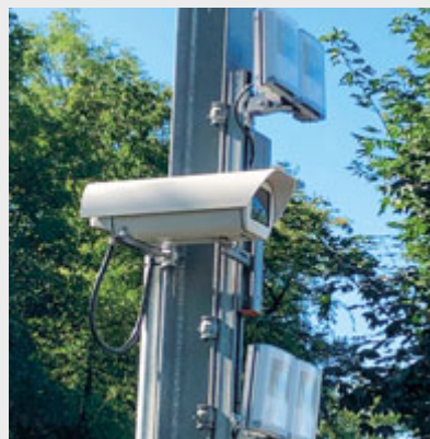
Das „digital rail gate“ ist mit hochauflösenden 2D-Kameras ausgestattet.
