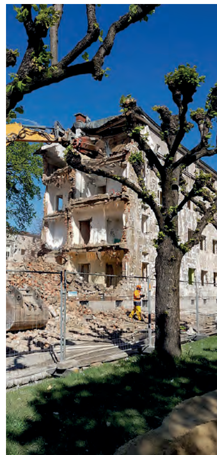
Die Abbrucharbeiten erfolgten im Frühjahr.
