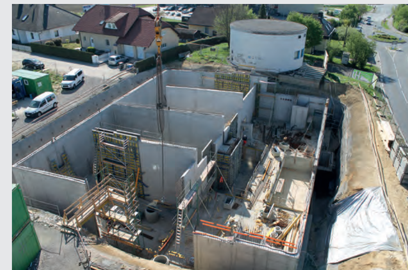
Beim Großprojekt „neuer Hochbehälter Hitzing“ von LINZ AG WASSER wurden bis Mai die Wände, die Behälterkammern und der Rohrkeller betoniert.
