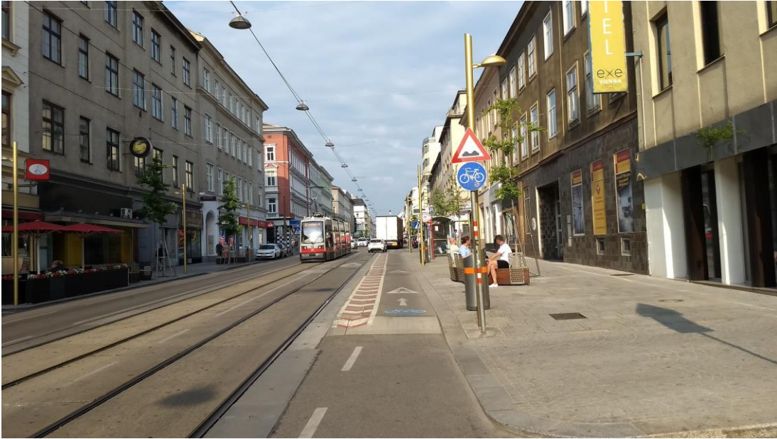
Abbildung 65: Befahrbares Haltestellenkap in Wien
