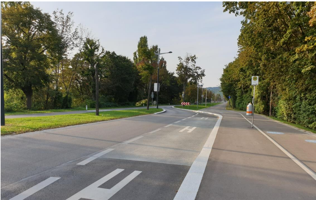
Abbildung 66: Bushaltestelle in Wien, Radweg wird hinter der Wartefläche vorbeigeführt
