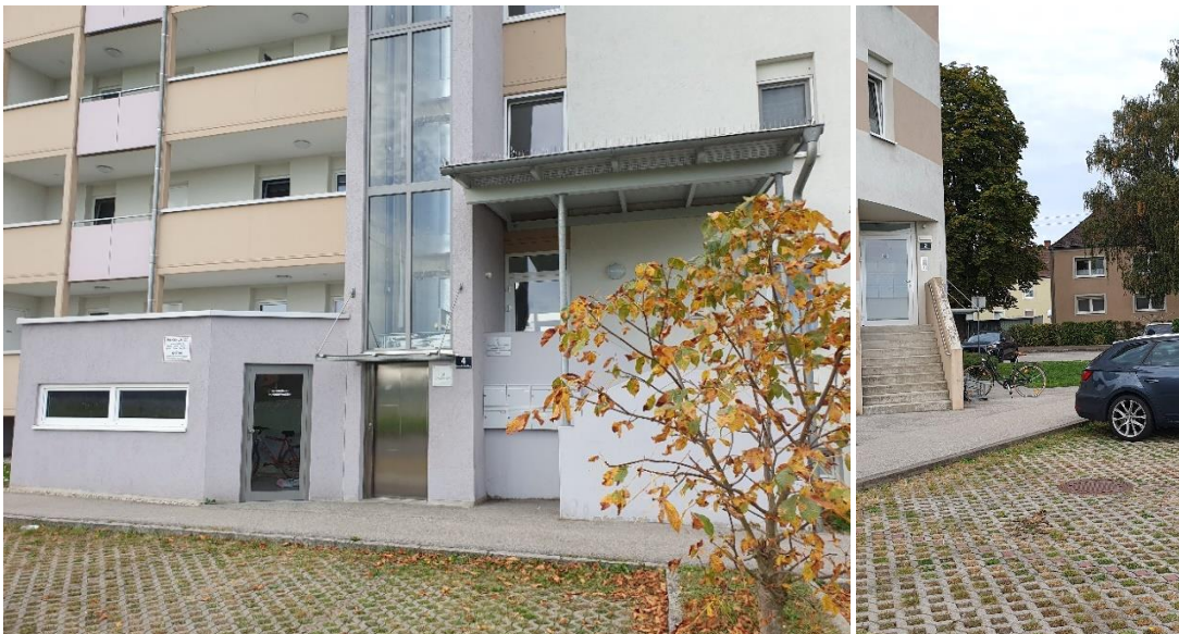
Abbildung 29: Fahrradraum (Glastür links) im Eingangsbereich des Wohnbaus; Vorderradklemmen für Besucher:innen (rechts) in Leonding Haag
