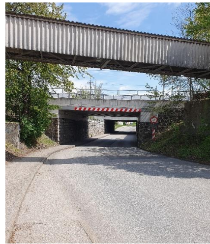
Abbildung 7: Turmstraße Bahnunterführung ohne Radweg
