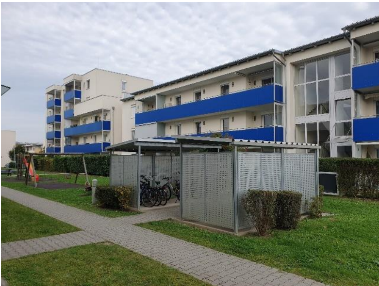
Abbildung 25: Überdachte Fahrradabstellanlage; Leonding Haag
