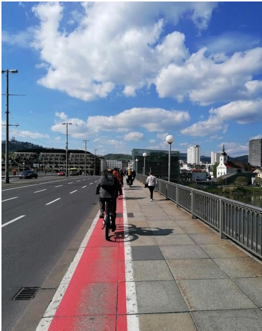
Abbildung 4: Radweg Nibelungenbrücke; Ende in Urfahr
