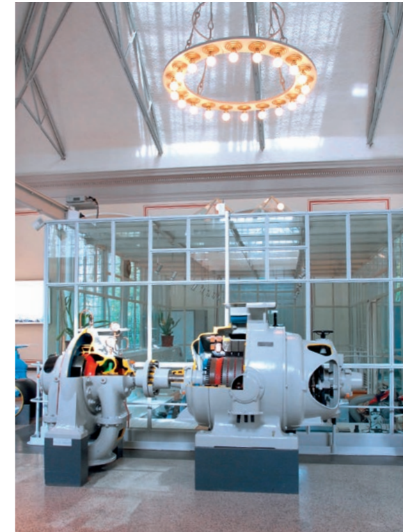
Wasserwelt Scharlinz: Leitzentrale und Besuchsraum.
