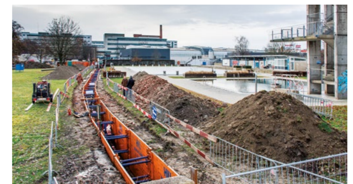
Kühle Köpfe an heißen Sommertagen: Die Tabakfabrik Linz ist seit dem Frühjahr an das umweltfreundliche Fernkältenetz der LINZ AG angeschlossen.
