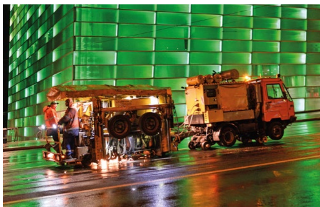
Schienenschleifarbeiten: Was auf dem Foto imposant aussieht, dient vor allem dem Komfort und der Sicherheit der Fahrgäste.
