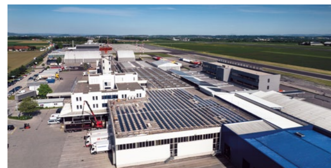
Bereits 2015 landete die LINZ AG mit der Errichtung einer großen Photovoltaikanlage am Flughafen Linz eine tolle Innovation.
