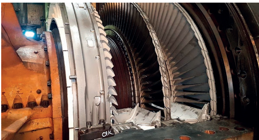
Imposant: die geöffnete Gasturbine mit Turbinenschaufel.
