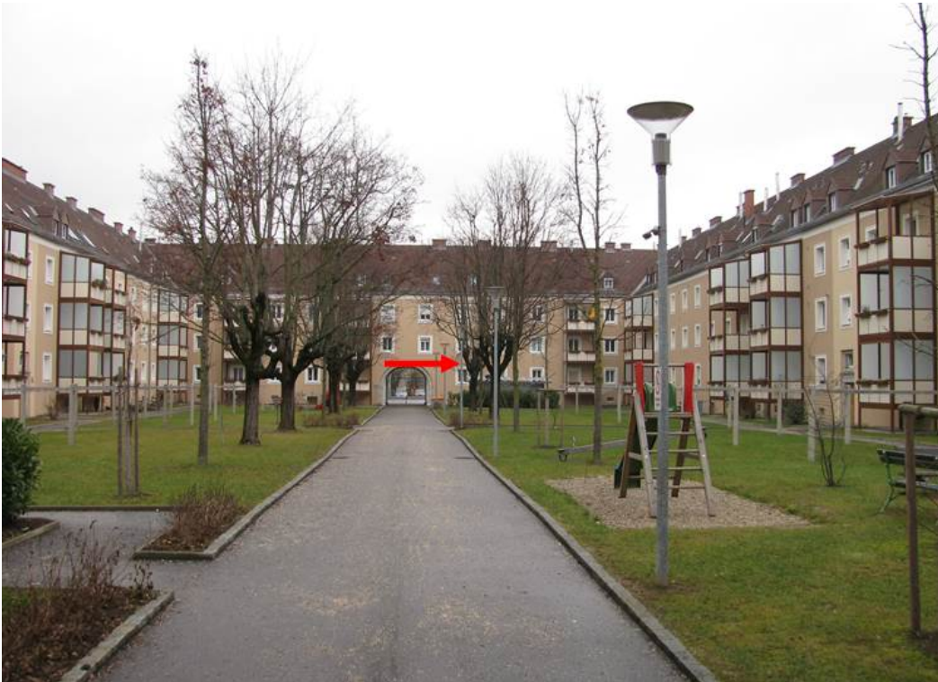
Anhang A, Foto 10: MP 48_ Urnenhain – Wohnanlage, Innenhof, Übersichtsbild
