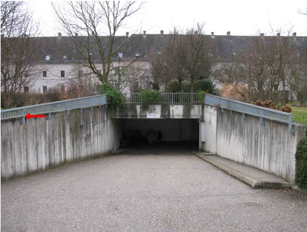
Anhang A, Foto 26: MP 62_ Spallerhof-Proschkogang, Übersichtsbild
