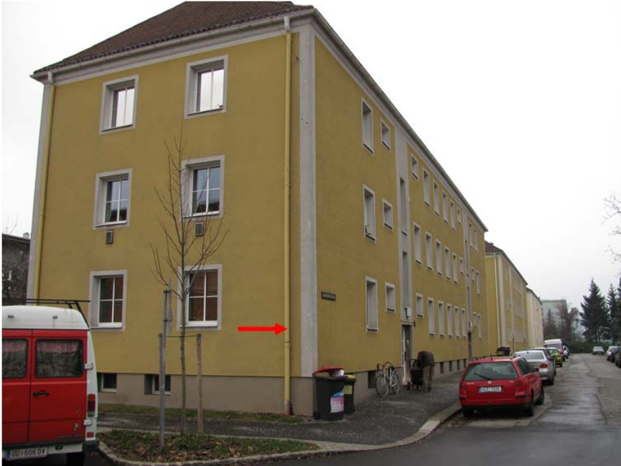
Anhang A, Foto 17: MP 55_ Semmelweisstraße, Übersichtsbild
